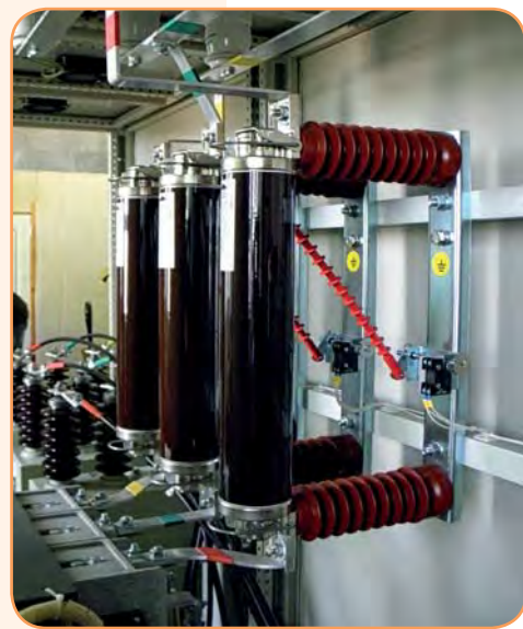
Установка внутренних держателей предохранителей*
