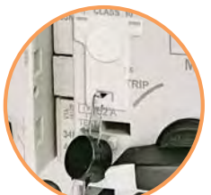
→ Пломбировочная панель регулировки тепловой защиты
