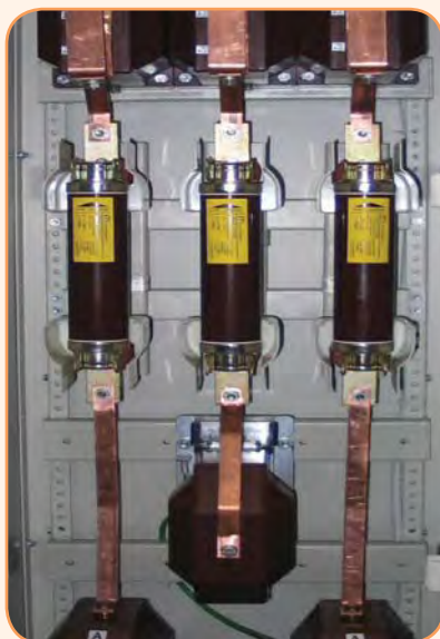
Внутренняя установка предохранителей
